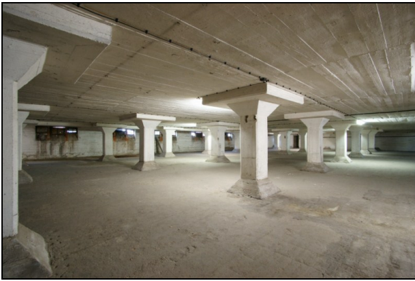
Links: Schuppen F (1940/41): Kelleranlage — einzigartige frühe Betonkonstruktionsweise mit Basis, Kapitel und Abakus. Mit Schallschutzwänden versehen die Lösung für die dringend benötigten Proberäume für Lübecks Jugendbands.
