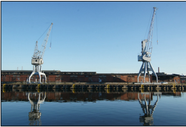
Schuppen F (Bj. 1941) mit den Portaldrehkränen Nr. 22 (Bj. 1953, Tragkraft 3 t) und Nr. 52 (Bj. 1967, Tragkraft 15 t) aus der ehemaligen Kampnagelfabrik in Hamburg. Sie sind die jüngeren zwei von vier noch erhaltenen Kranen von ehemals 21 Kranfahrten auf der Nördlichen Wallhalbinsel. Die beiden anderen (der Halbportalkran am Kaufmannsspeicher/ den Media-docks, und der Bockdrehkran an der Nordspitze der
