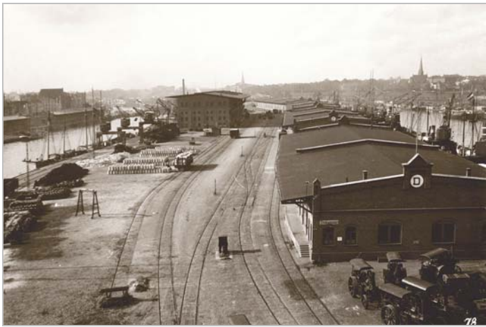
Nördliche Wallhalbinsel von Norden, Aufnahme vor 1939: Zwischen dem zentralen Gleisfächer und den Außengleisen liegen die „Terrains für Kaischuppen“, wie sie in der Rehder-Planung bezeichnet werden. Hier entstehen zwischen 1894 und 1907 nach und nach der Kaufmannsspeicher und die Schuppen A bis D. Der Schuppen F folgt auf dem Freifeld links im Bild erst 1939. Foto: Appel.
