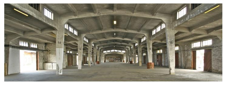
Bild oben: Die große Halle von Süden nach Norden. An einen Mittelrahmen sind jeweils zwei einhüftige Seitenrahmen angehängt. Dadurch kann das Dach gestaffelt werden und einen Lichtgaden ausbilden. Foto: Thomas Radbruch.
