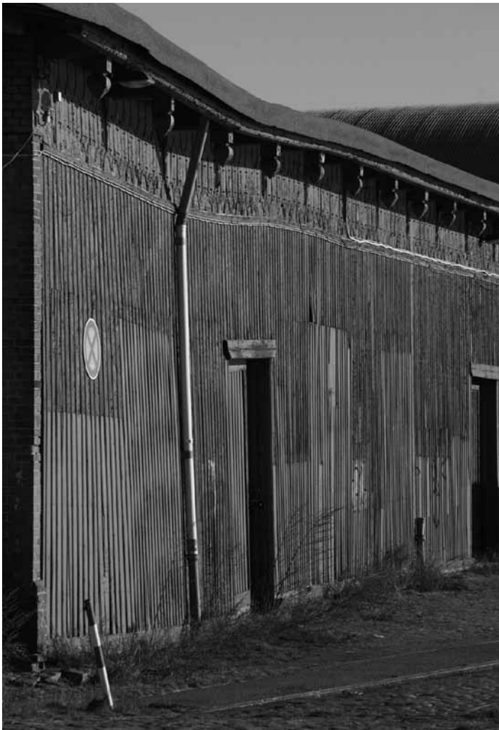
Links: Die 1905 technisch und stilistisch exakt ausgeführte Erweiterung des nördlichen Schuppens 11. Die in jüngerer Zeit zugesetzten Schiebetore zeichnen sich deutlich in der Holzverkleidung ab. Die Sanierungsplanung sieht vor, diese ehemaligen Tore zu öffnen und
