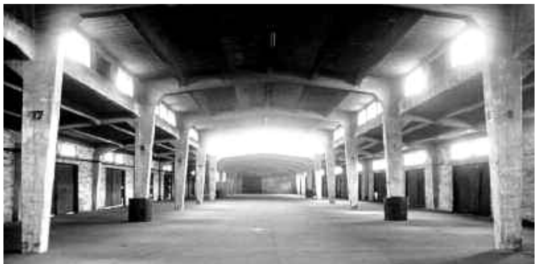
Schuppen F, eine solide, auch ästhetisch ansprechende Betonkonstruktion mit umlaufendem Oberlicht-Band. Ein wunderbarer Saal für Groß-Veranstaltungen
