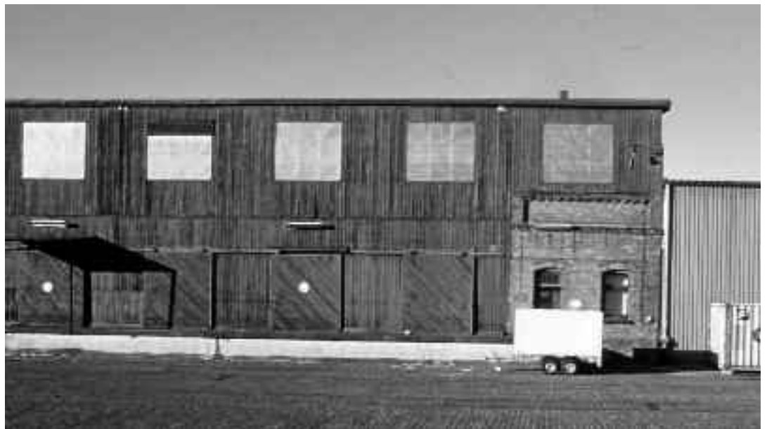
Schuppen C von der stadtzugewandten Seite. Zweigeschossige, solide Ziegel-Holz-Konstruktion. Unten durchgehend Schiebetore, oben große (jetzt vernagelte) Fensterbänder
