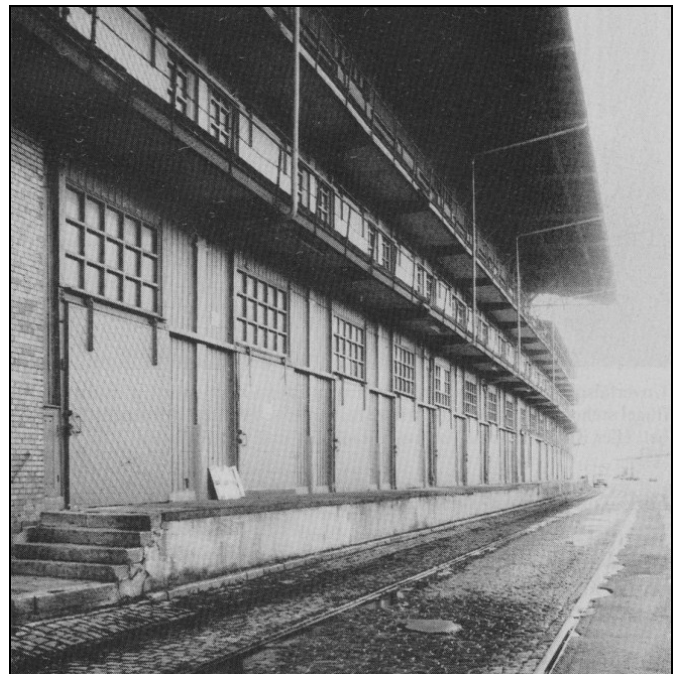
Der große Schuppen von 1892, 3-4stöckig, ein Eisenskelettbau mit verbretterten Außenfronten. heute nur noch teilweise mit vergiftetem EG-„Subventionsgetreide“ belegt, ansonsten leer und „nutzlos“.
