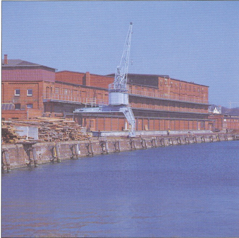
Das 1897/98 erbaute Lagerhaus wurde im Zweiten Weltkrieg teilweise zerstört.
