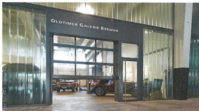
Tor-Durchblick: Nur die verglasten Sektionaltore erlauben den ungetrübten Blick in die Räume.
